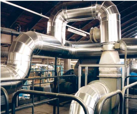
شكل (٤) صورة تبين كيفية الاستفادة من غازات العادم الساخنة مرة اخرى بنقلها الى أماكن التجفيف أو تسخين غازات الاشتعال
