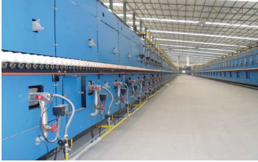
شكل (٣) فرن حريق سريع
